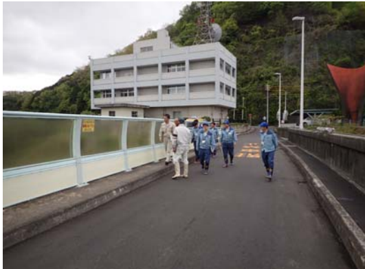
ダム天端道路点検状況
